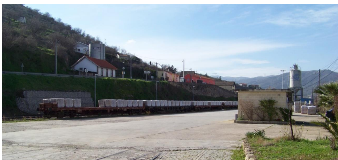
Figura 10 - Estação Ferroviária do Pocinho
